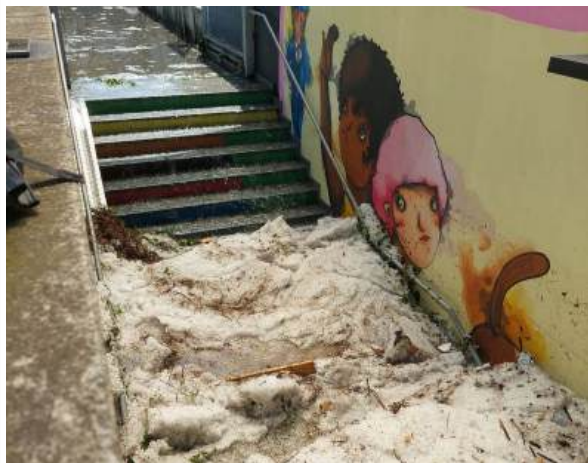
Seregno Sottopasso della stazione ferroviaria
